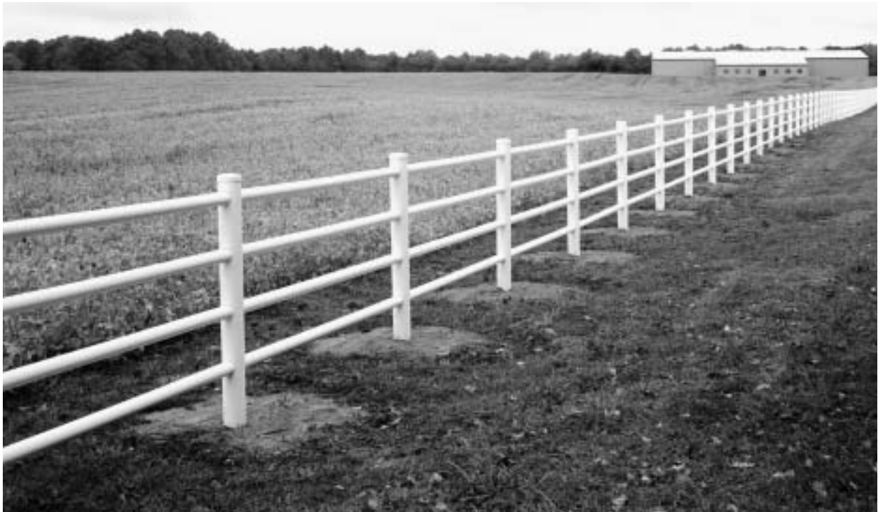
Modelo com coluna e travessa circular recortada.
