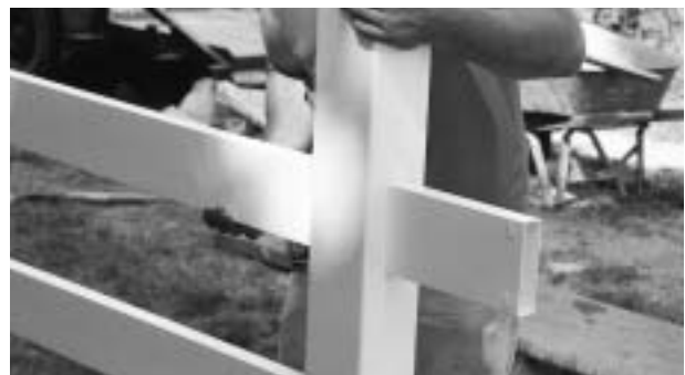
As travessas são passadas através das colunas pré-recortadas.
