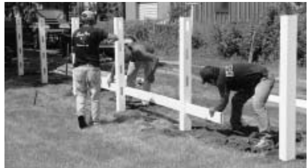
Encaixando as primeiras travessas, começando pela parte inferior. Se o espaço permitir, as travessas são balanceadas nas uniões.
