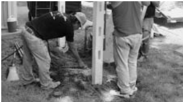
Buracos cavados, colunas alinhadas e socadas inicialmente em cimento seco, água está sendo acrescentada para assentar as colunas.
